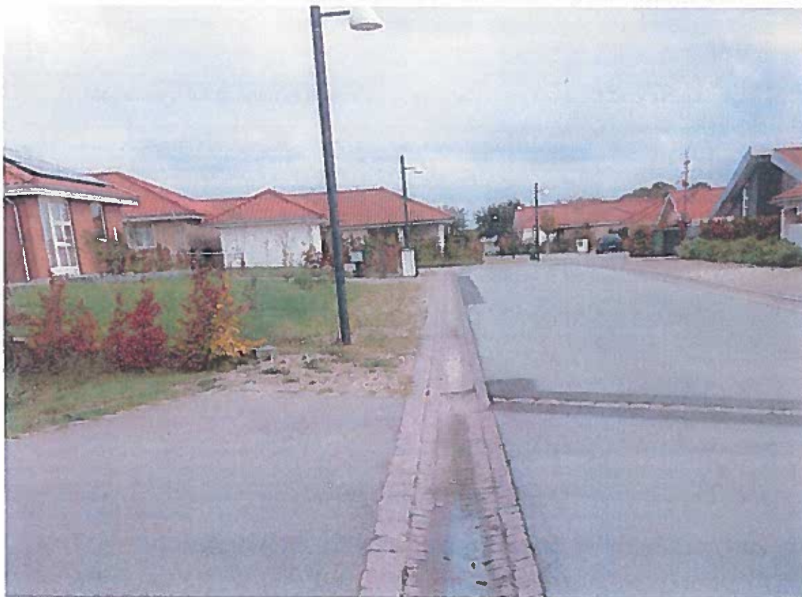
Figur 4.3 Trug med belægningssten.
