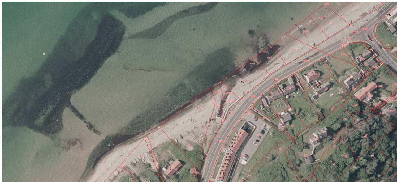
Billede 17: Luftfoto af Rågeleje - herunder resterne af havnemolen, Eksisterende forhold, 2005 (kilde: Billedet er samlet ved at sakse i de tilgængelige luftfoto, Gribskov kommune har lagt på nettet)
